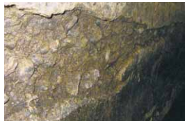
Risse und Spalten in der Grubenwand führen zu undichten Behältern. In beiden Fällen ist eine Sanierung notwendig.
