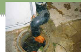
Alte Ableitungen in der Grubenwand sind dauerhaft mit einer Spezialmasse zuzumauern.
